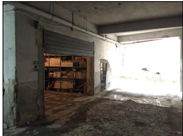
Fig.12 Veduta verso la zona di transito
