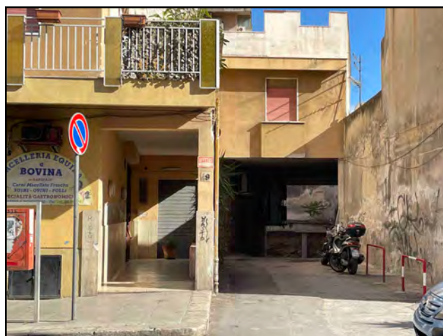
Fig.6 Accesso al piano scantinato civ.46
