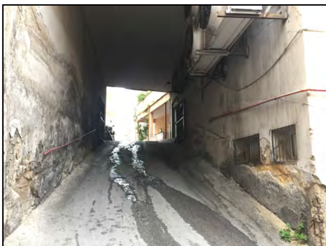
Fig.7 Rampa di accesso al piano scantinato
