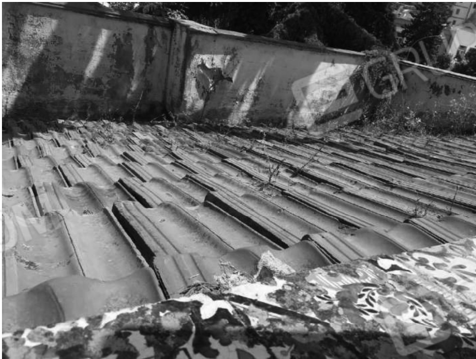
Foto n. 40 Copertura a falde
