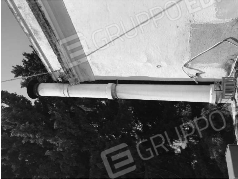
Foto n. 41 Canna fumaria in cemento amianto
