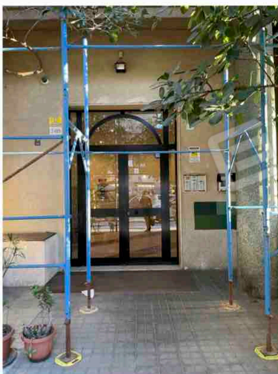
Fotografia n. 6 - ingresso alla portineria
