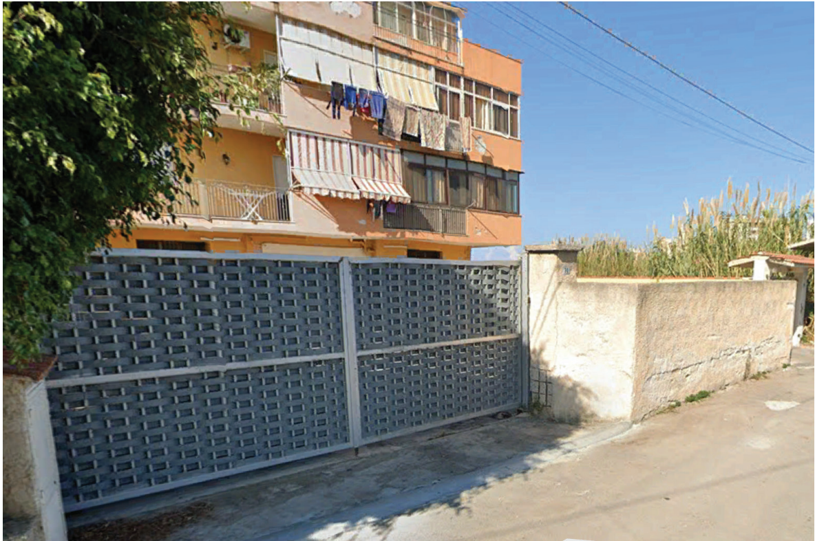
4 Prospetto est dell'edificio
