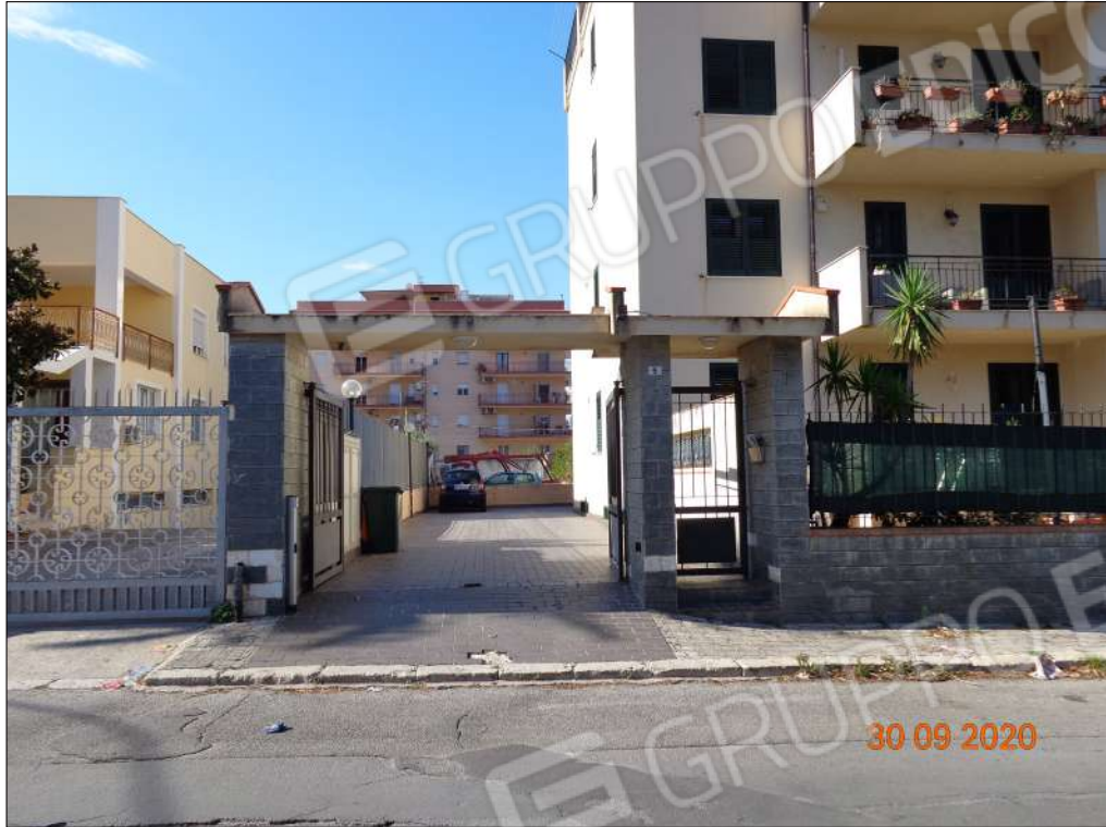
Foto n. 3 - Vista esterna dei cancelli di ingresso
