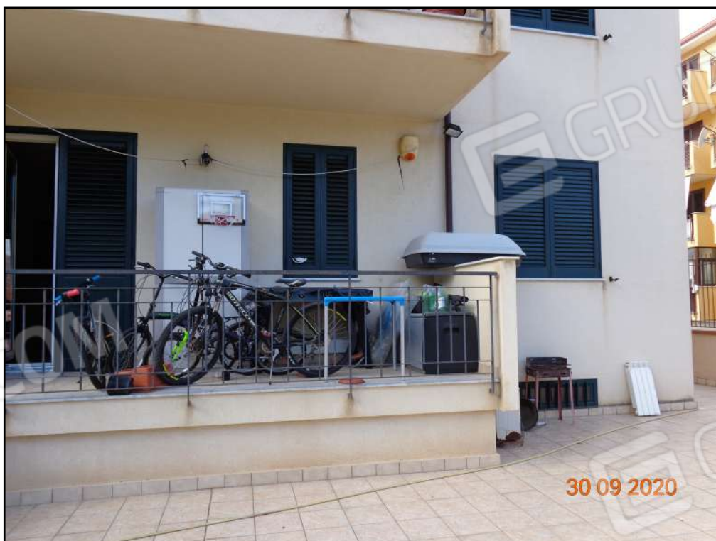
Foto n. 18 - Esterni: Balcone su corte di pertinenza
