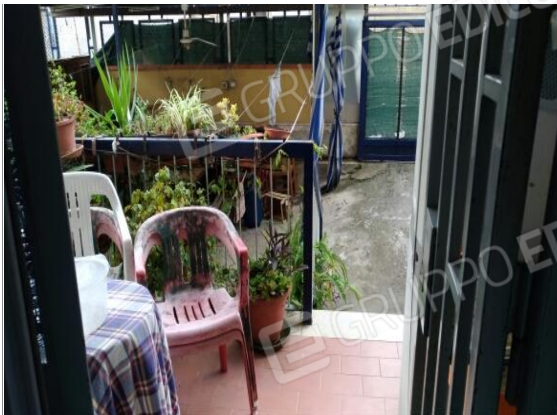
FOTO 41– Porta finestra e grata in ferro di accesso al balcone e alla striscia di terra adibita a giardino e parcheggio
