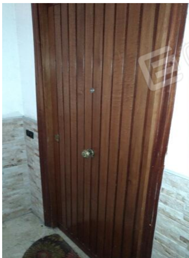
FOTO 8 – Porta in legno di accesso all'appartamento
