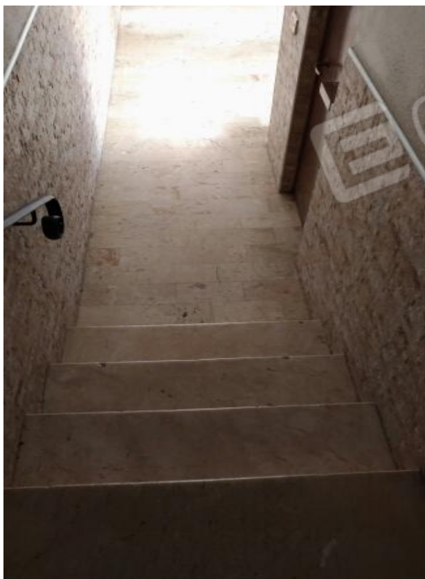
FOTO 6 – Rampa di scale con corrimano in ferro
