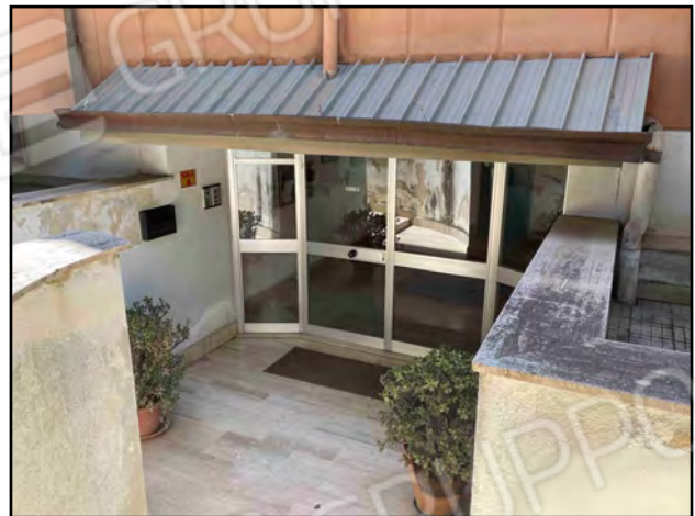
Accesso al corpo scala A
