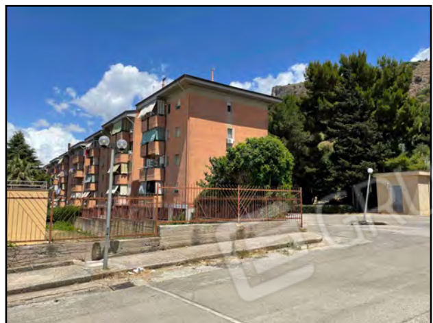
Testata sud-ovest del fabbricato
