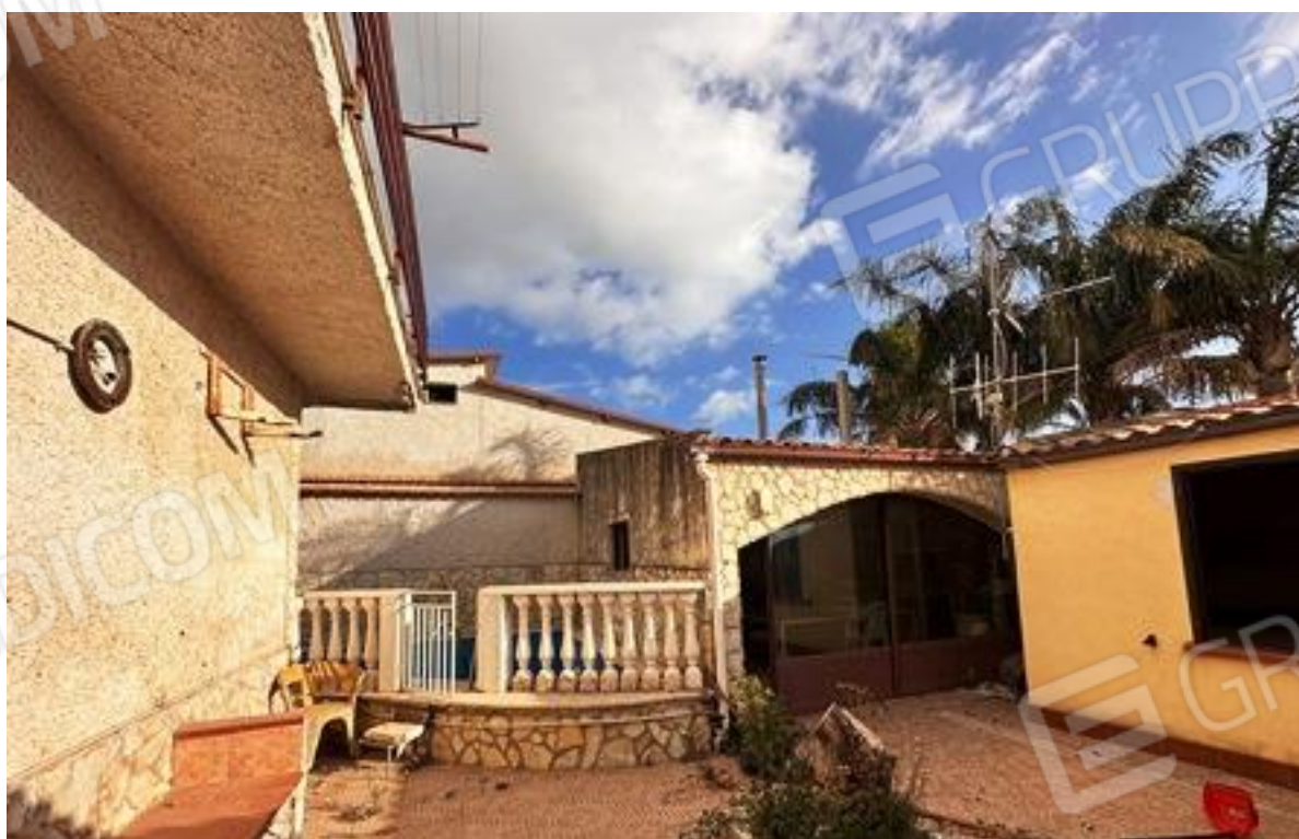
Foto n. 4 - Retrospetto e secondo corpo accessorio.
