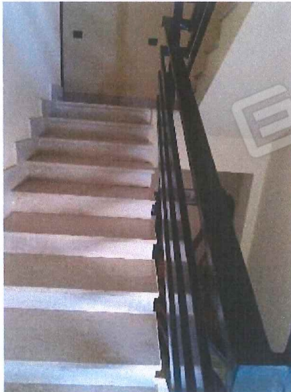
FOTO 6 – Rampa di scale con ringhiera in ferro
