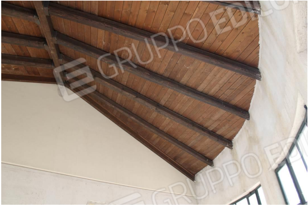
Immagine D3 – 15 Particolare – copertura
