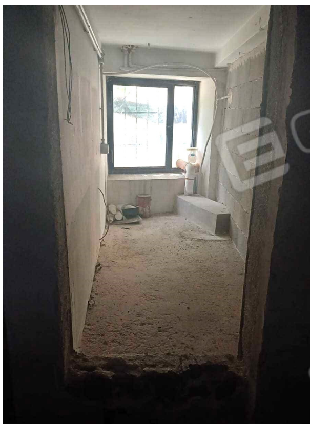
Foto n.9 – locale realizzato sul soppalco
