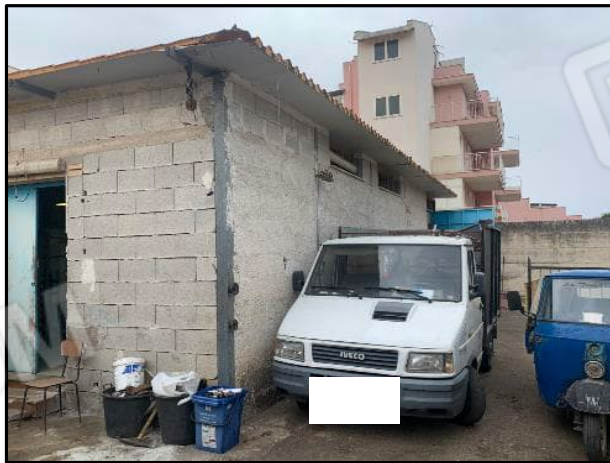
Corte esterna comune
