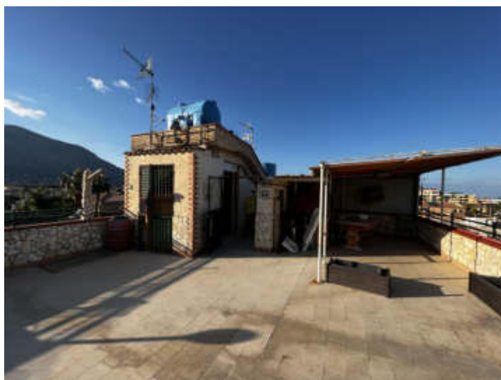
porzione di lastrico solare al piano 2°
