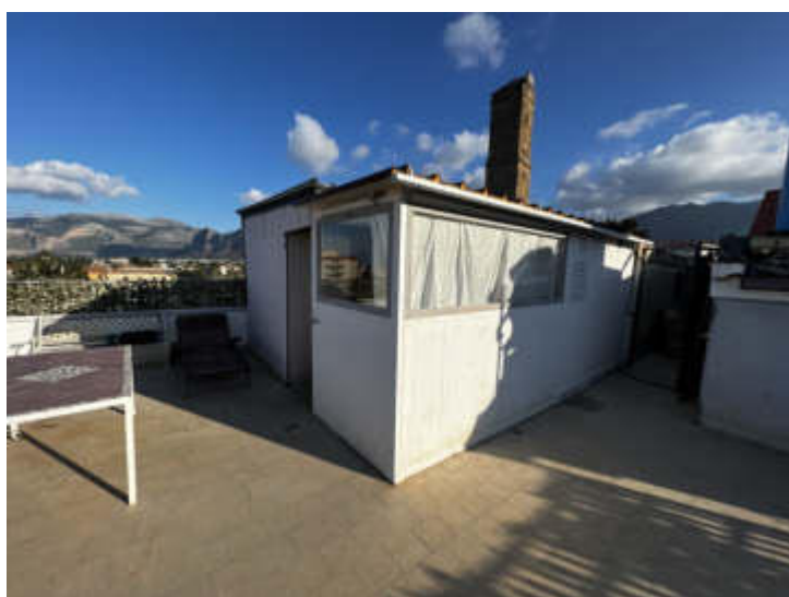
porzione di lastrico solare al piano 2°
