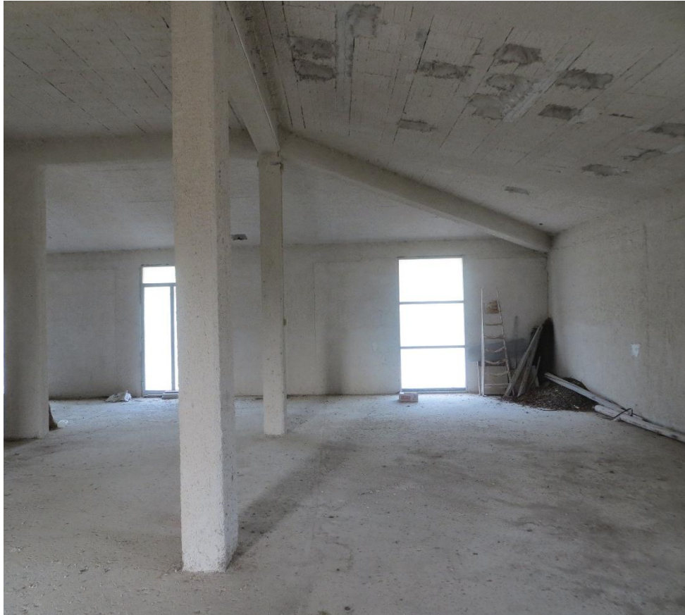
Foto 7. Secondo piano dell'edificio in corso di costruzione. Zona a destra salendo le scale corrispondente al subalterno 14
