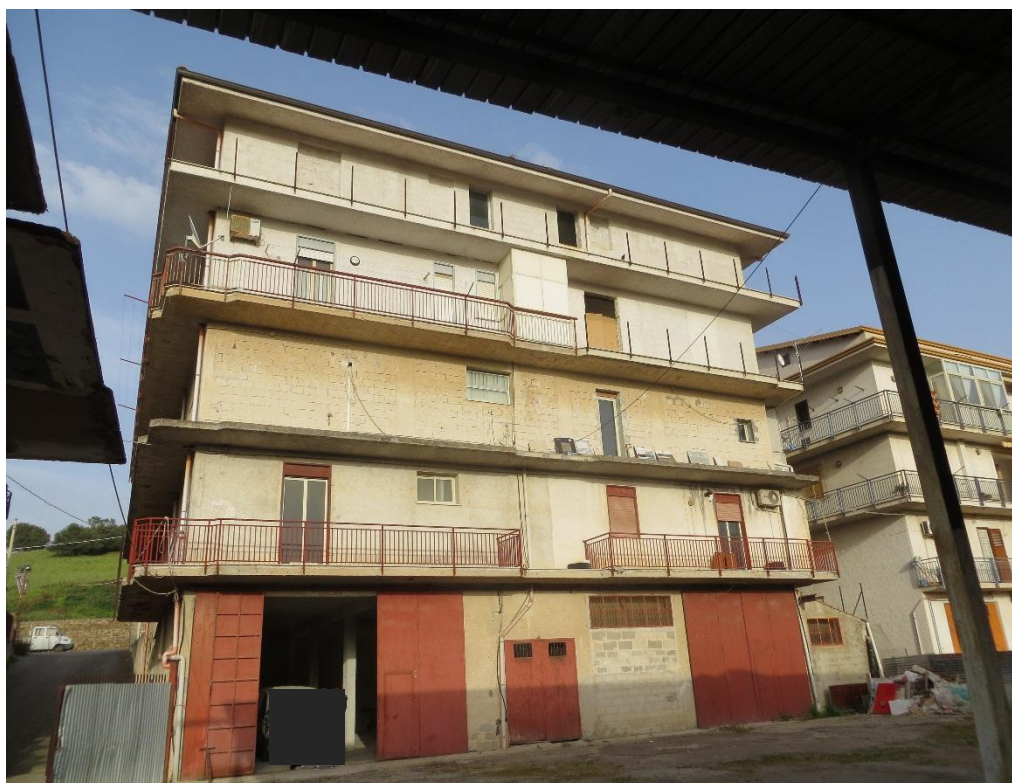
Foto 2. Prospetto opposto alla strada con cortile antistante.
