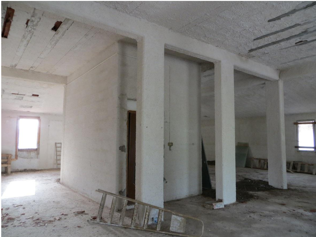
Foto 4. Secondo piano dell'edificio. Scala di accesso
