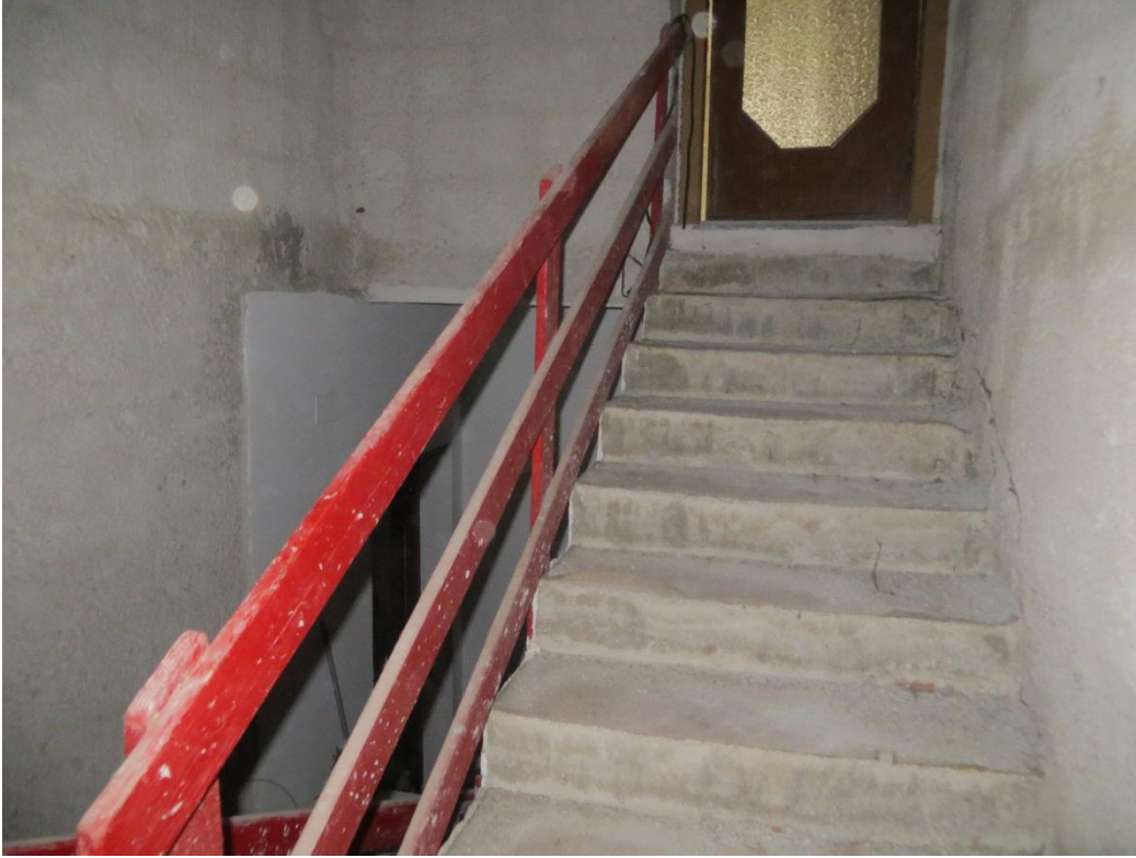
Foto 3. Scala di accesso al secondo piano.
