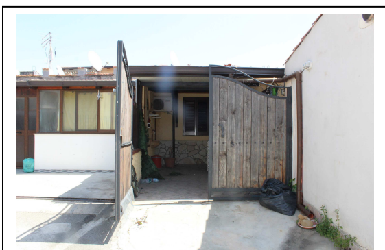
Ingresso allo spazio esterno di pertinenza esclusiva (Area A)
