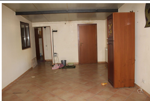
Ingresso (Vano 1) e accesso alla cucina, lavanderia e area di pertinenza esclusiva (Area B).
