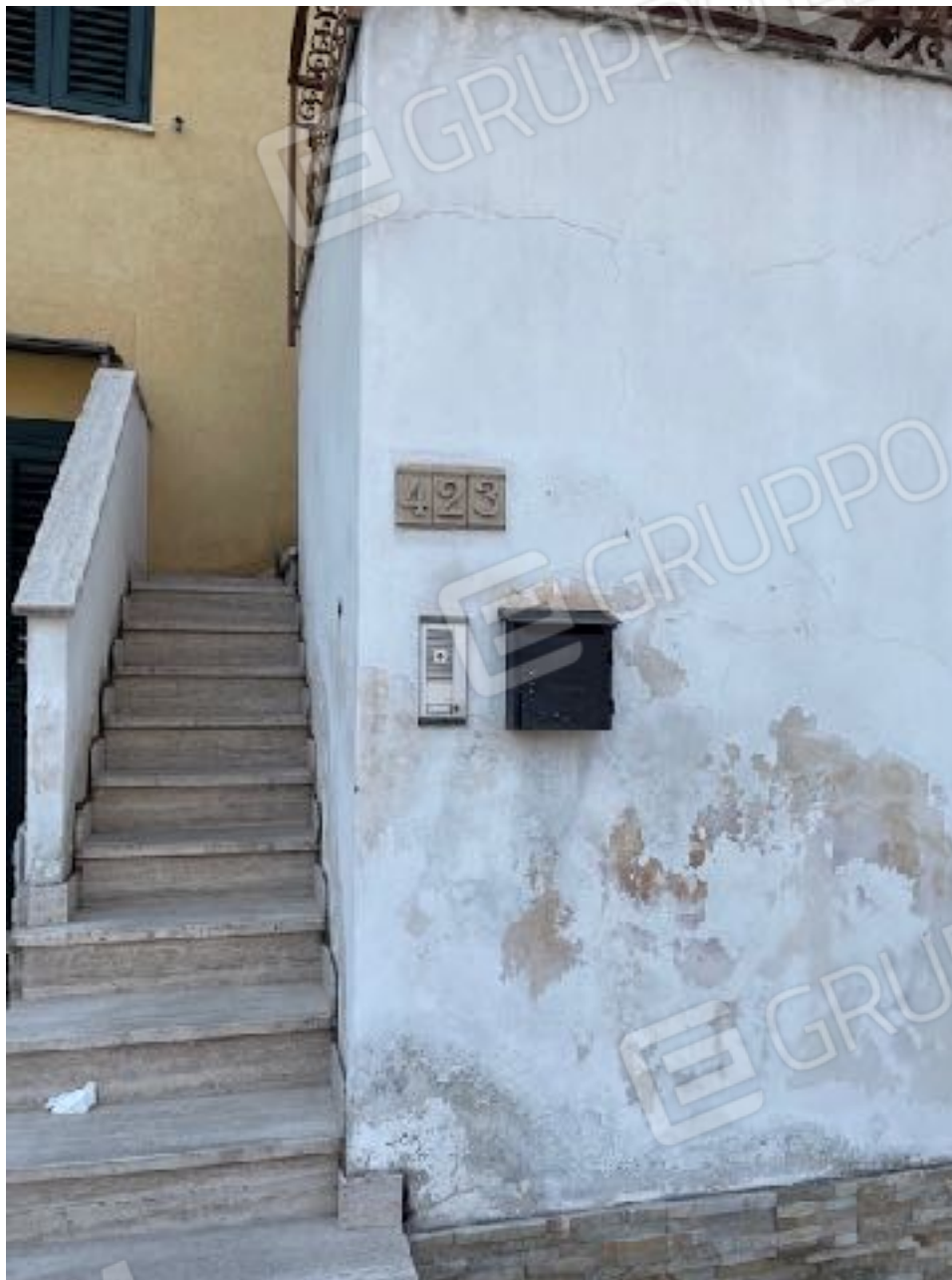
Foto 12 particolare scala muratura di accesso all'immobile
