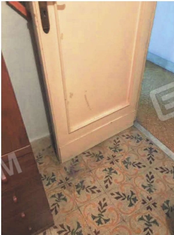
Foto n.16 Particolare pavimentazione e porta del ripostiglio
