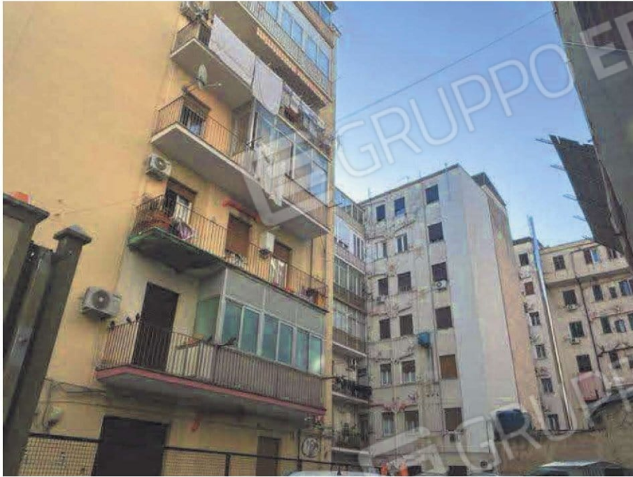
Foto n.3 Vista dell'edificio da via Simone Cuccia
