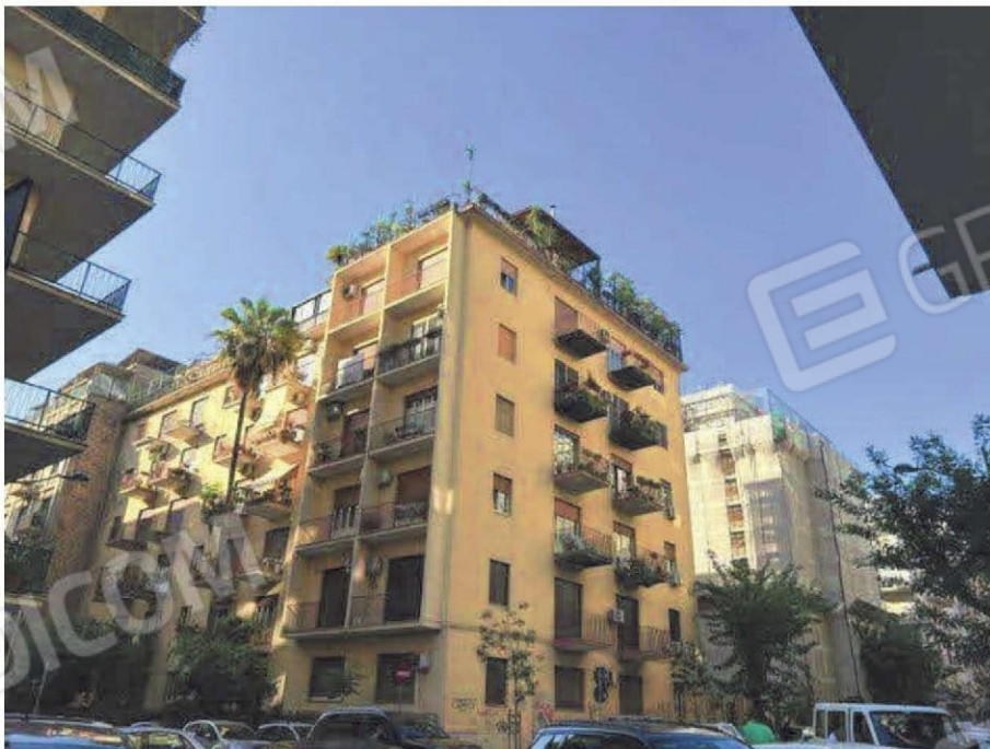
Foto n. 2 Vista dell'edificio da via Simone Cuccia
