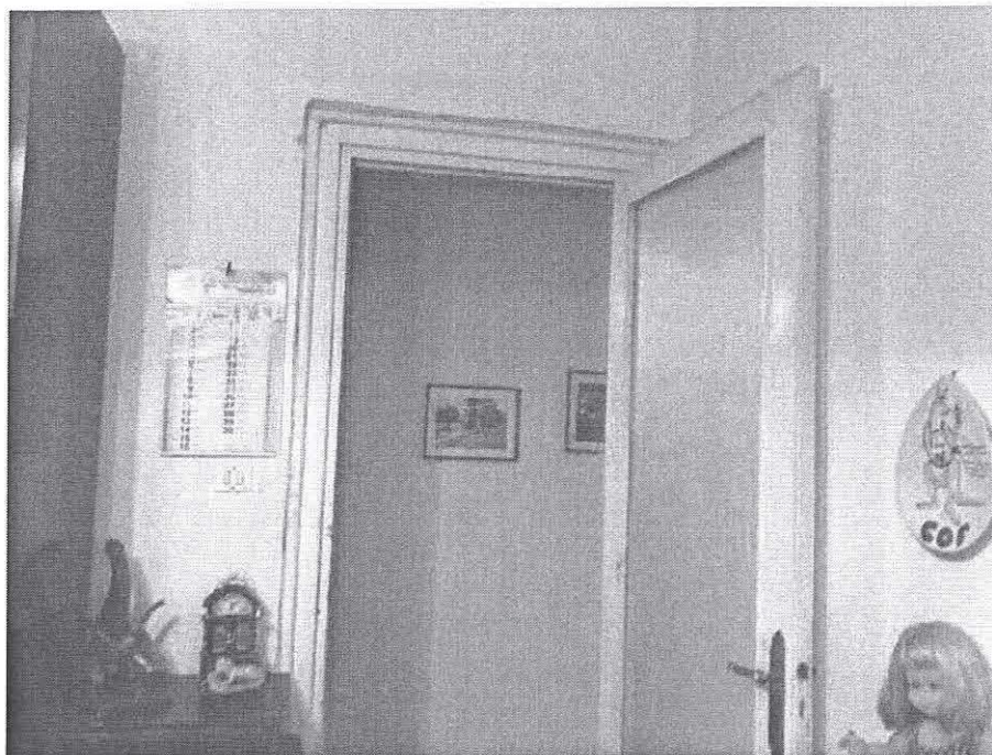
PARTICOLARE IMPIANTI A VISTA E PORTA INTERNA
