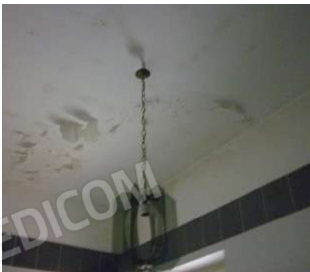
Foto n. 11 – Servizio igienico che ricade nella porzione di immobile che appartiene all'immobile limitrofo
