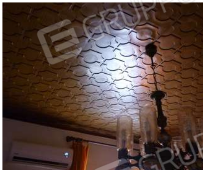
Foto n. 12 – Controsoffitto della zona soggiorno
