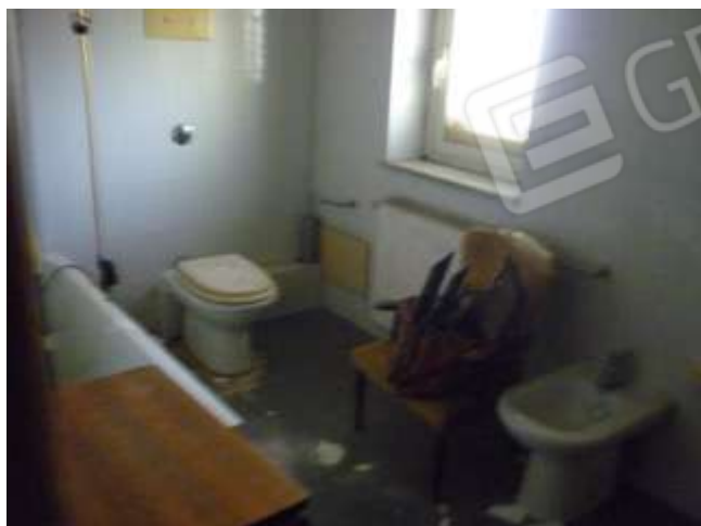
Foto n. 9 – Servizio igienico che ricade nella porzione di immobile che appartiene all'immobile limitrofo
