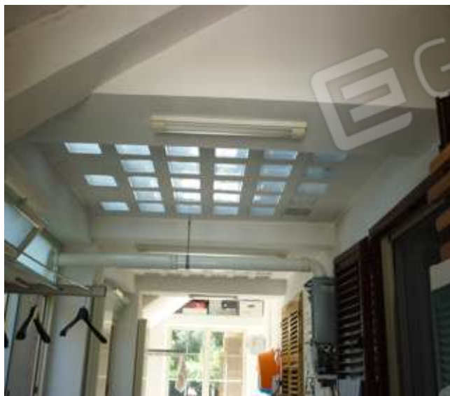
Foto n. 21 – Interno locale lavanderia
