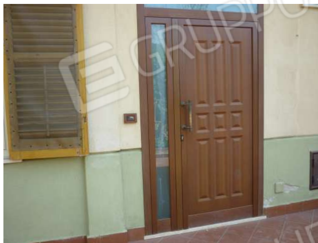
Foto n. 11 – Porta di ingresso all'immobile
