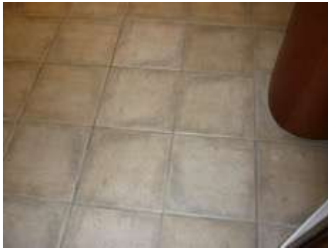
Pavimentazione in ceramica
