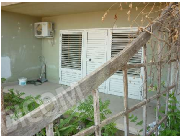
Foto n. 3 – Portico di accesso all'immobile
