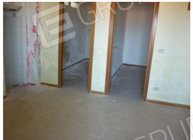
Foto n. 4 – Vista interna del locale
