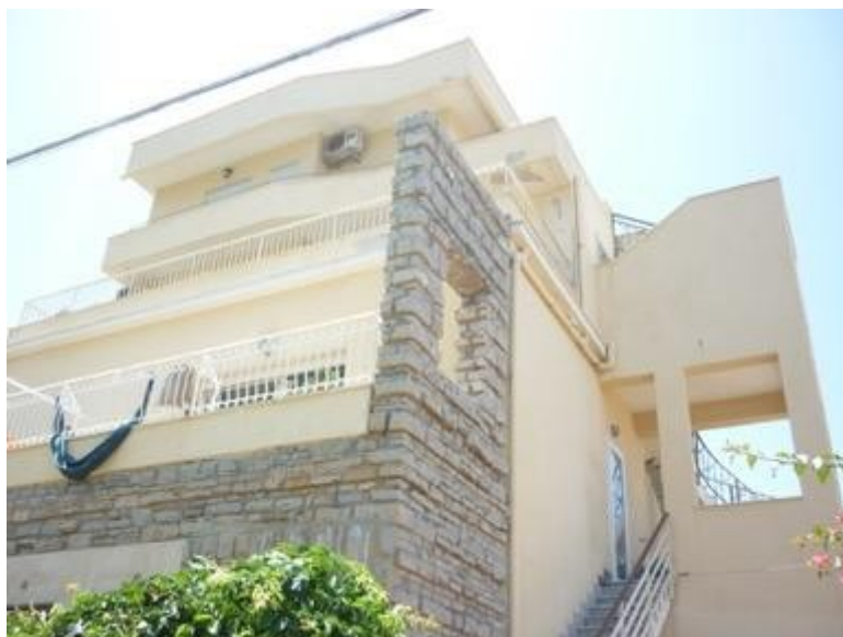
Foto dell'immobile sito in Palermo (Sferracavallo) via Virgilio n. 3-5
