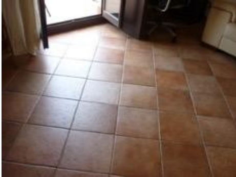
Pavimentazione in ceramica
