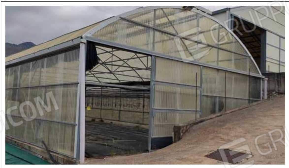
Foto n. 6: La terza serra e, più in alto, il capannone.
