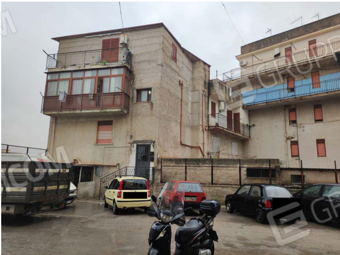
FOTO 2: Vista palazzina con accesso dal civ. 27
