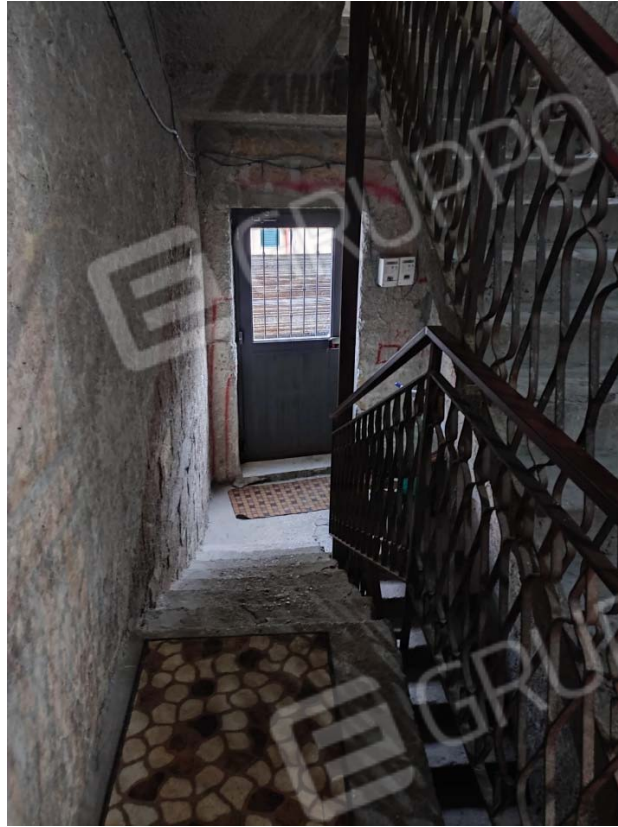
FOTO 3: Scala di accesso
