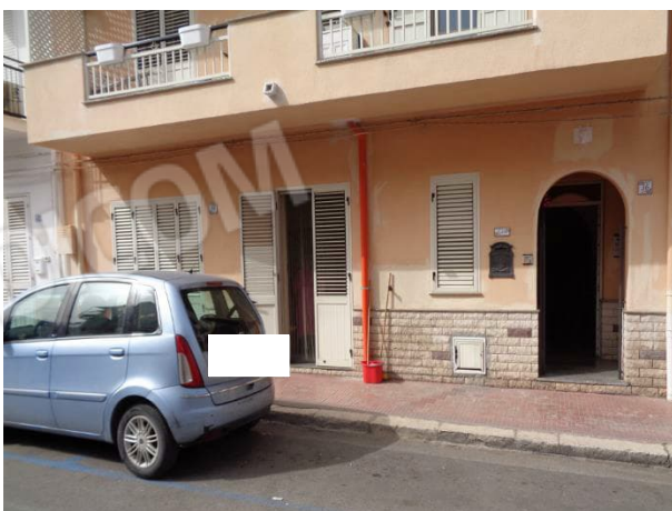
Ingressi piano terra
