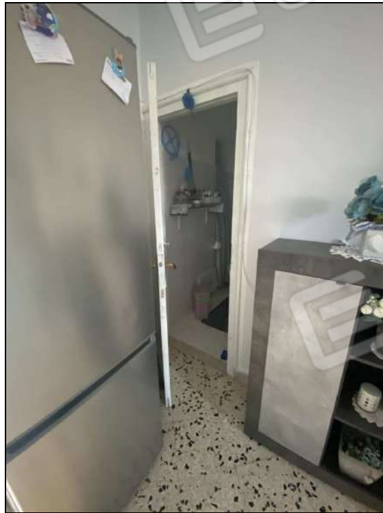
Foto n. 3,4 : piano primo vano cucina e lavanderia
