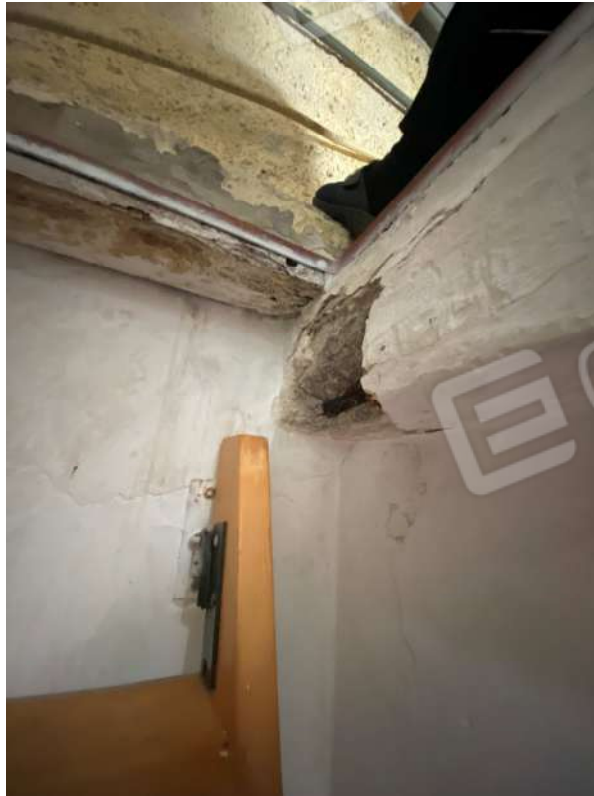
Foto 7,8,9: piano secondo Secondo vano - w.c. e accesso alla soffitta
