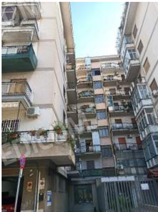
Accesso condominiale su via Ribera
