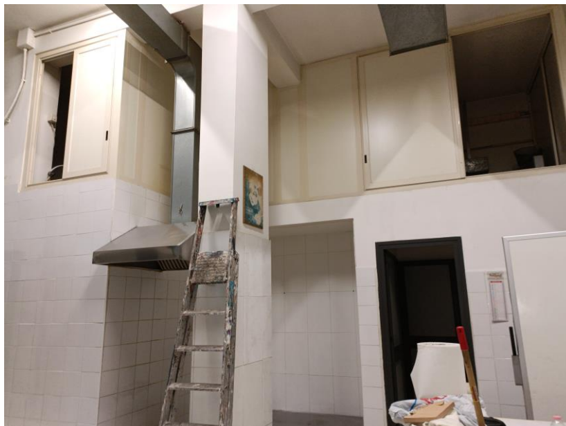
Foto n. 4 – Interni. Viste del soppalco (locale tecnico)
