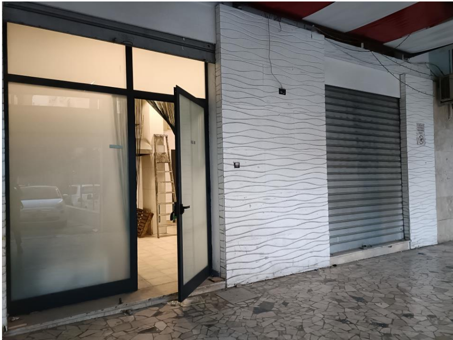
Foto n. 3 – I due accessi ai magazzini
