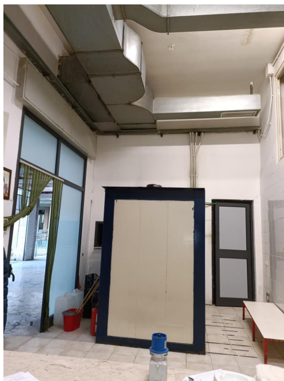
Foto n. 5 – Interni attualmente occupati da macchinari a uso laboratorio di cucina, che saranno sgomberati dagli stessi.
