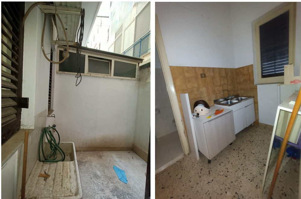
Foto 15-16 – Terrazzino lato unità A e cucinino unità A
