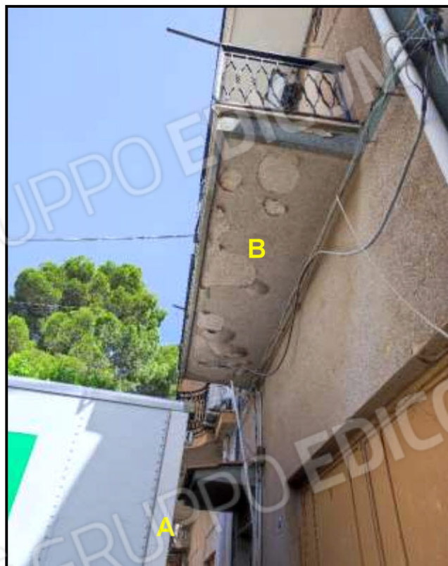
Foto N°2 - (A) Accesso alle unità immobiliari; (B) Balcone Laboratorio sub.12
