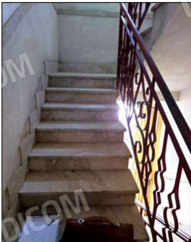
Foto N°7 - Rampa di accesso con gradini in marmo
