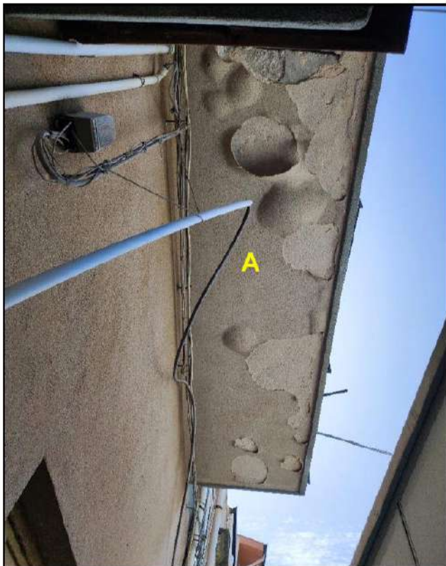
Foto N°3 - (A) Part. intradosso del balcone del Laboratorio (sub. 12) con rigonfiamento e distacco di intonaci ammalorati
