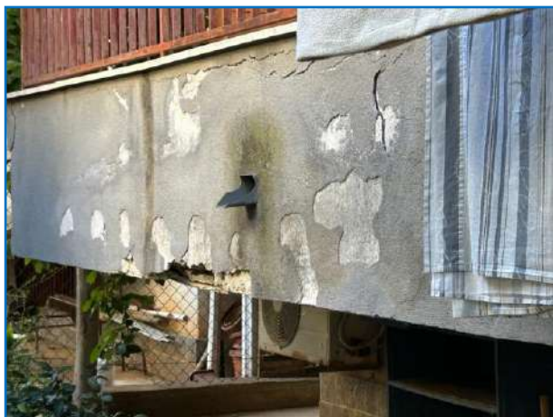
Foto n. 15 Ammaloramento balcone retro prospetto
