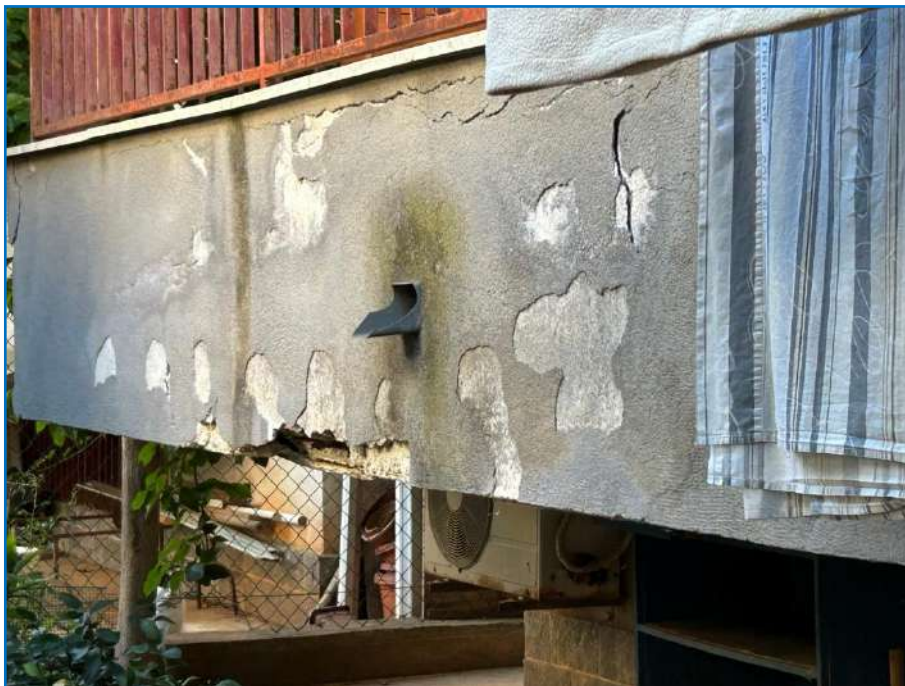
Foto n.15 Ammaloramento balcone retro prospetto
