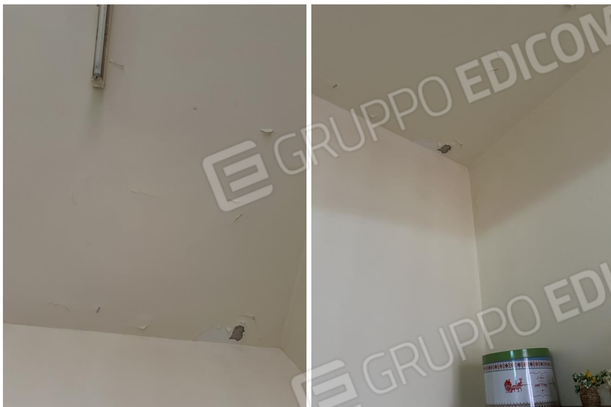
Figura 23-24: Vista degli ammaloramenti presenti sull'intradosso del solaio del vano cucina/soggiorno
