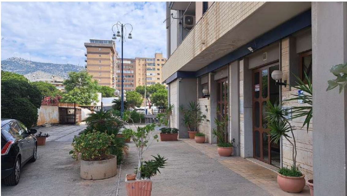
Foto n. 3 – accesso all’edificio e spazio esterno condominiale
