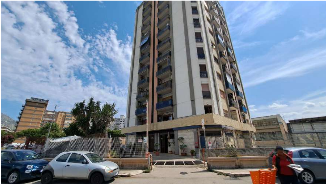
Foto n. 2– prospetto principale e laterale
