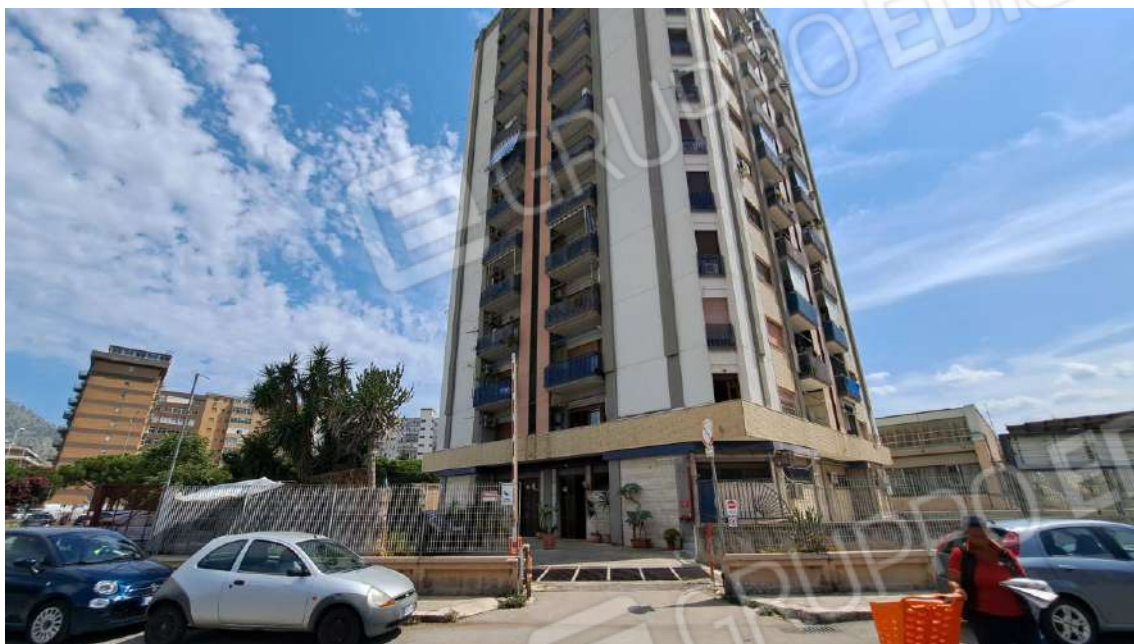
Foto n. 2– prospetto principale e laterale
