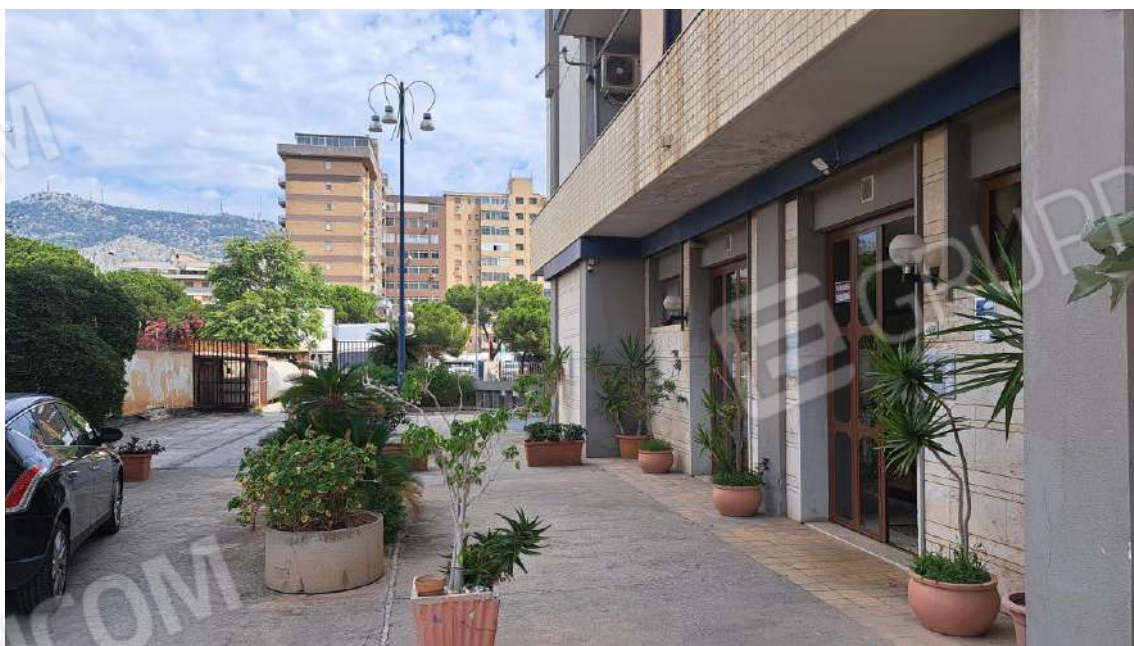
Foto n. 3 – accesso all’edificio e spazio esterno condominiale
