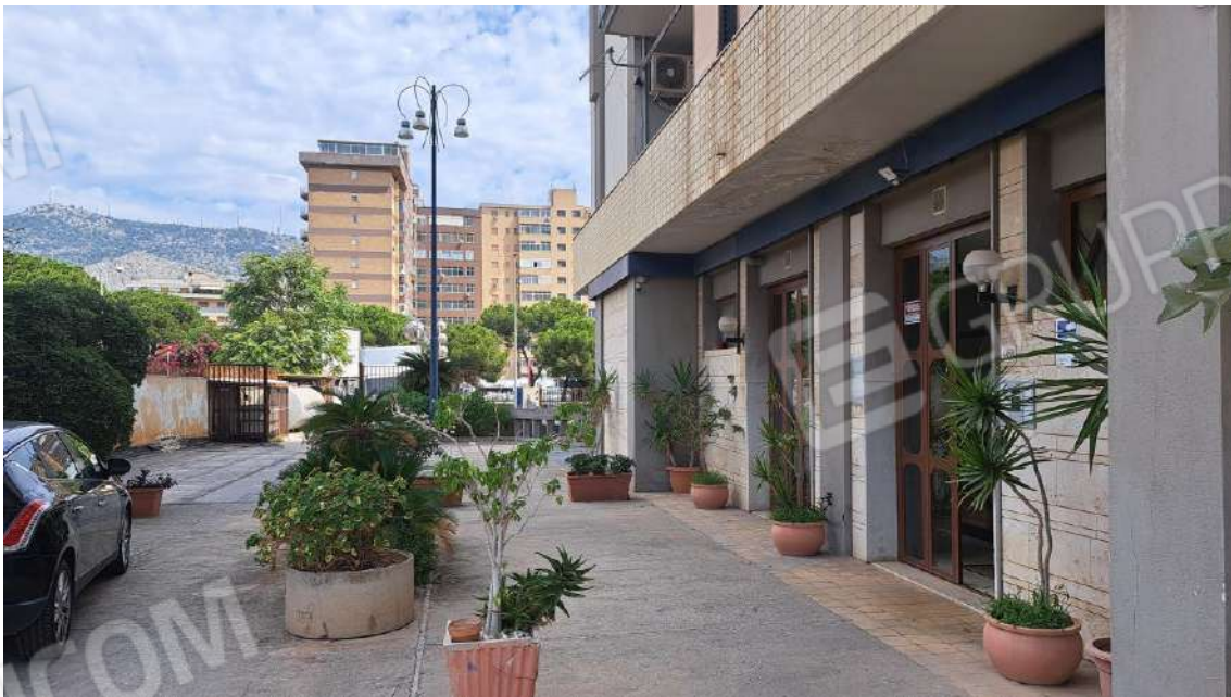
Foto n. 3 – accesso all’edificio e spazio esterno condominiale
