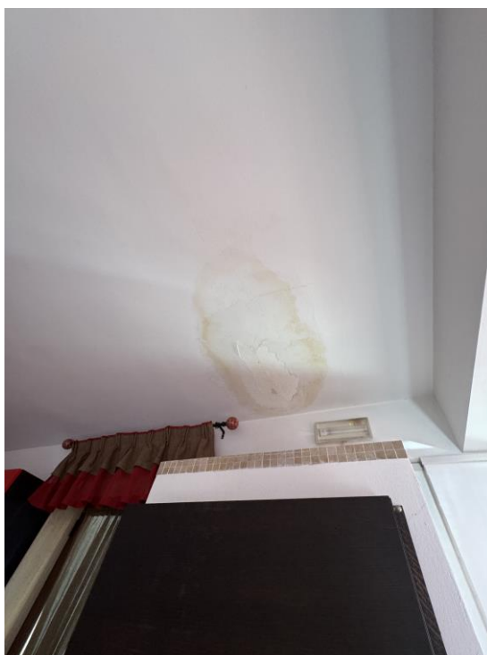
Foto n. 8 – L'infiltrazione sul tetto della cucina
