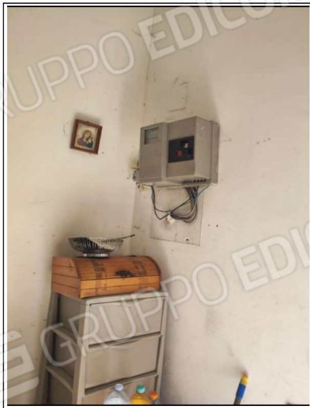
Foto N°10 - Part. quadro elettrico e contatore ENEL
