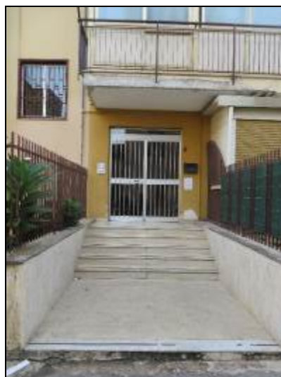
Portone di ingresso dell'edificio
