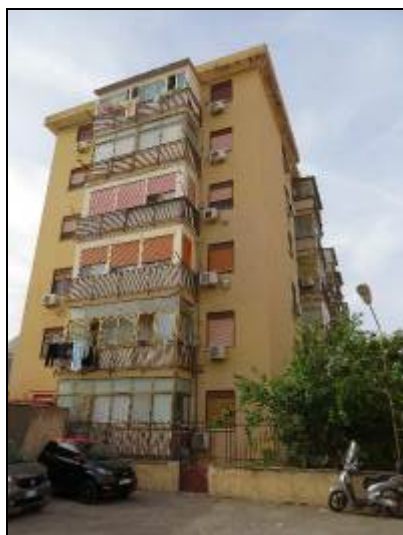
Prospetto laterale dell'edificio
