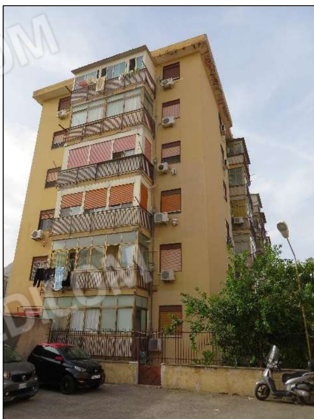
Prospetto laterale dell'edificio
