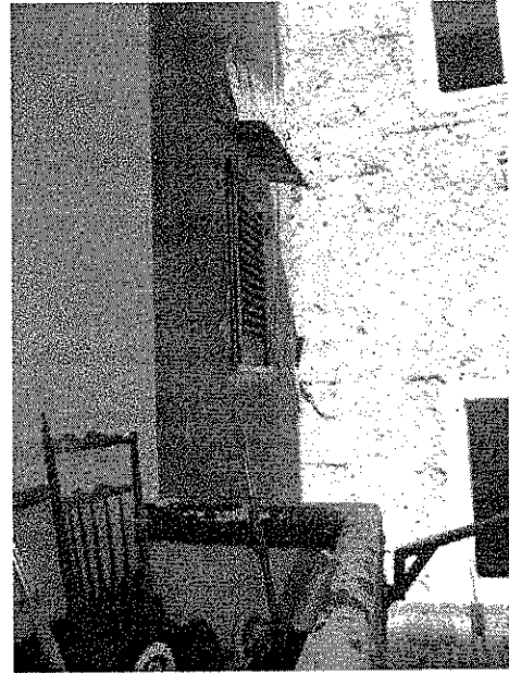
Fig. 29 Finestra bagno vista dall'esterno.
