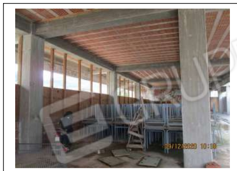
Foto 88. Edificio in corso di costruzione. Interno
