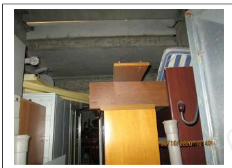
Foto 49. Locale di sgombero sotto la gradonata esterna
