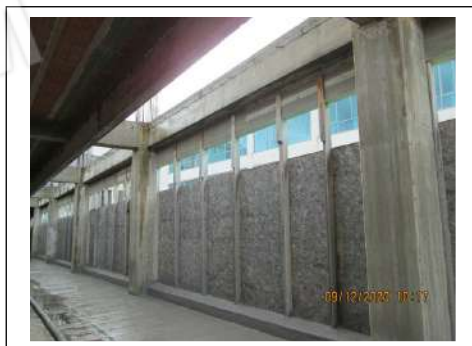
Foto 87. Edificio in corso di costruzione. Interno
