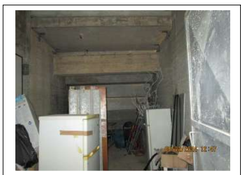
Foto 51. Locale di sgombero sotto la gradonata esterna
