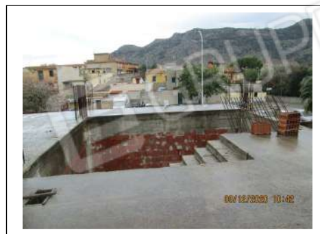
Foto 80. Edificio in corso di costruzione. Estradosso del solaio del piano terra e corpo scala
