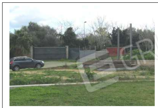
Foto 17. Cancelli di ingresso da via Casino Grande
