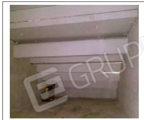
Foto 52. Locale di sgombero sotto la gradonata esterna
