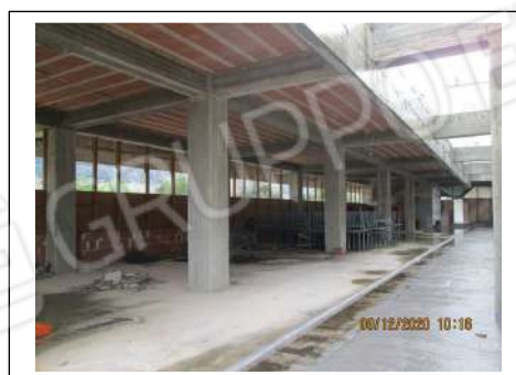
Foto 86. Edificio in corso di costruzione. Interno
