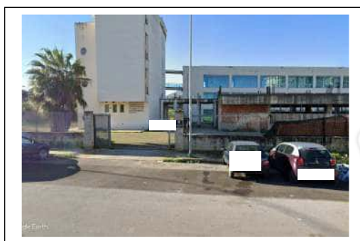
Foto 71. Ingresso da via Eleonora Duse n. 2
