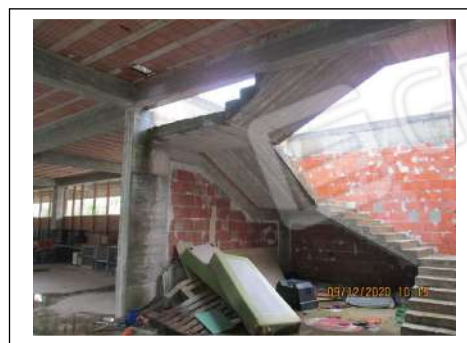
Foto 82. Edificio in corso di costruzione. Corpo scala
