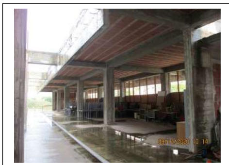
Foto 85. Edificio in corso di costruzione. Interno
