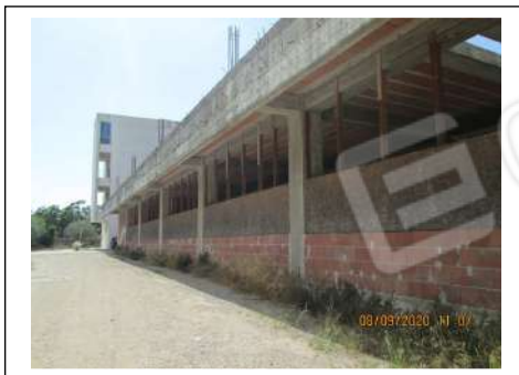
Foto 75. Edificio in corso di costruzione. Lato est
