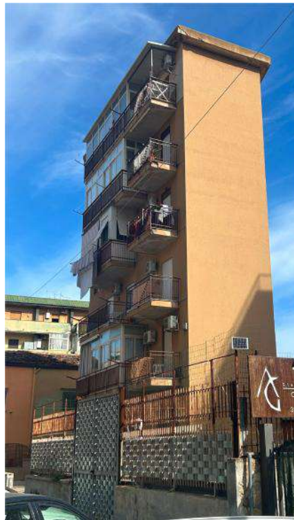
Foto n. 2 - L'edificio lateralmente (l'appartamento è al primo piano)
