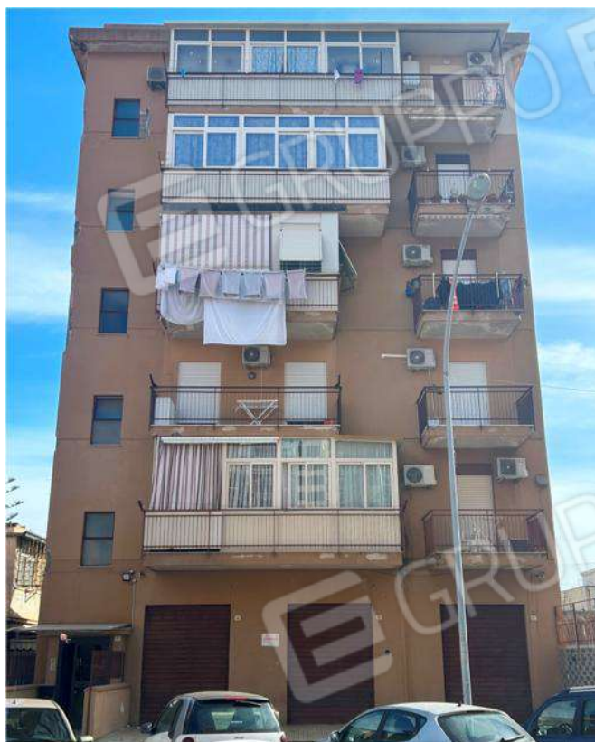
Foto n. 1 - L'edificio frontalmente (l'appartamento è al primo piano)
