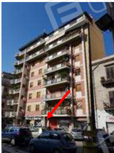
Foto n. 2 - Prospetto su Via Sampolo
