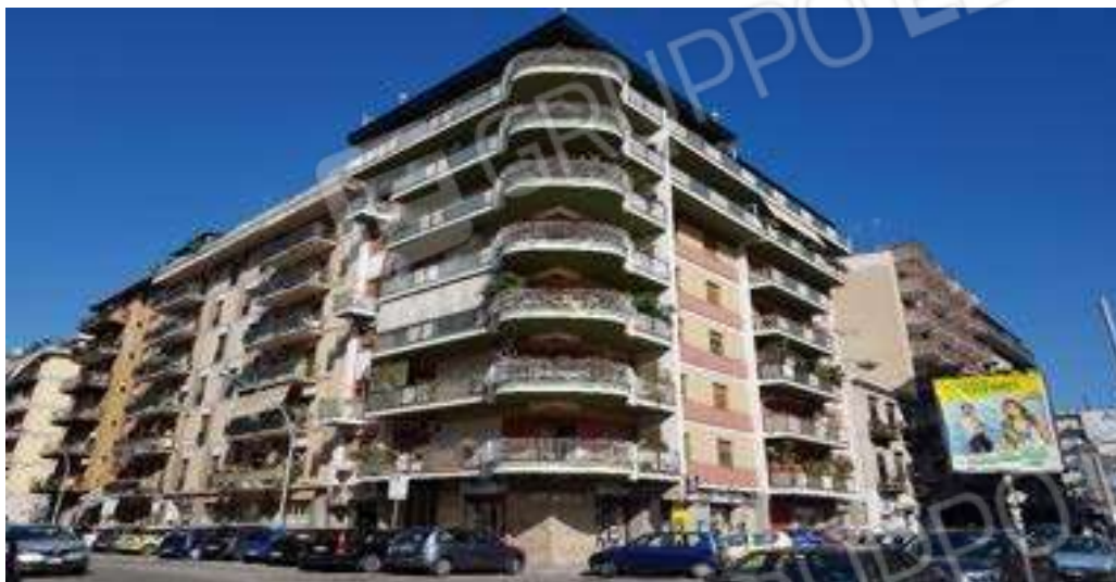
Foto n. 1 - Edificio condominiale Via De Cosmi angolo Via Sampolo
