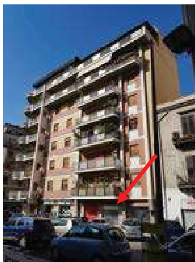
Foto n. 2 - Prospetto su Via Sampolo
