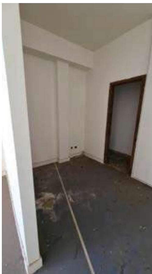
Foto n. 7 - Via Sampolo civ. 288 – interno locale commerciale – retro-negozio
